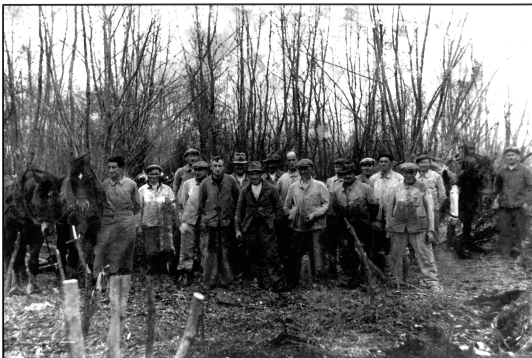
1. Défrichage des terres pour cultiver les patates (1940-1944) Patrimoine au fil de l'eau, Orbe
