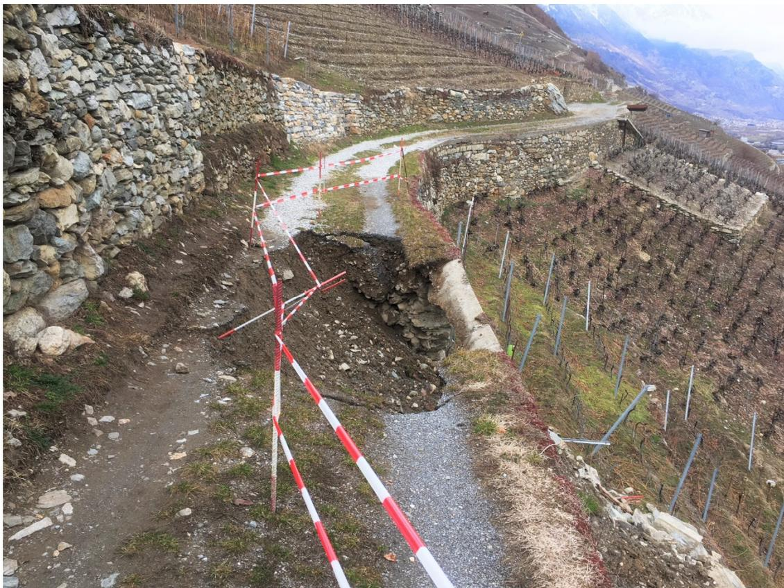
Abb. 1: Eingestürzte Stützmauer und Totalschaden am Weg im Weinberg in Terrassenlage in Martigny VS
