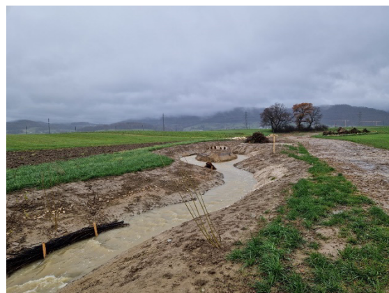
Kurz nach Bauende testen Starkniederschläge den Diebachgraben.
