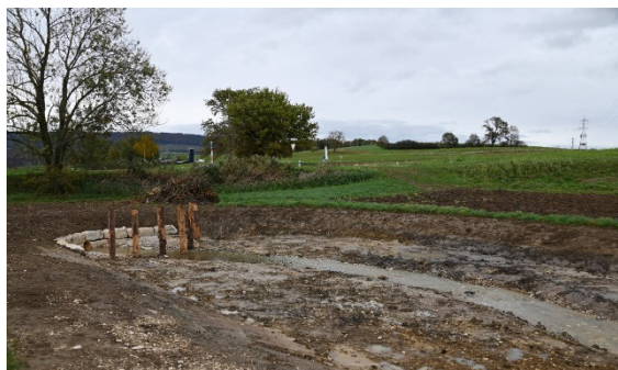
Das Rückhaltebecken dient als Auffangbecken für abgeschwemmtes Material und bietet bei Starkniederschlägen Platz für die Wassermenge.
