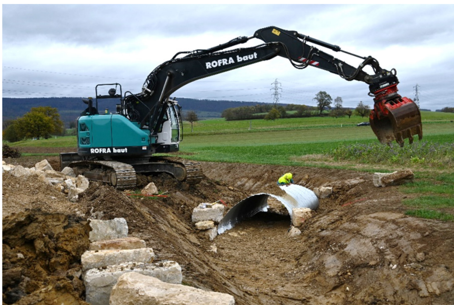
Einbau des Wellstahlrohrs bei der Querung der Gasleitung.
