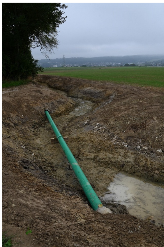
Die alte Bachdole dient während dem Bau stellenweise als Wasserhaltung.
