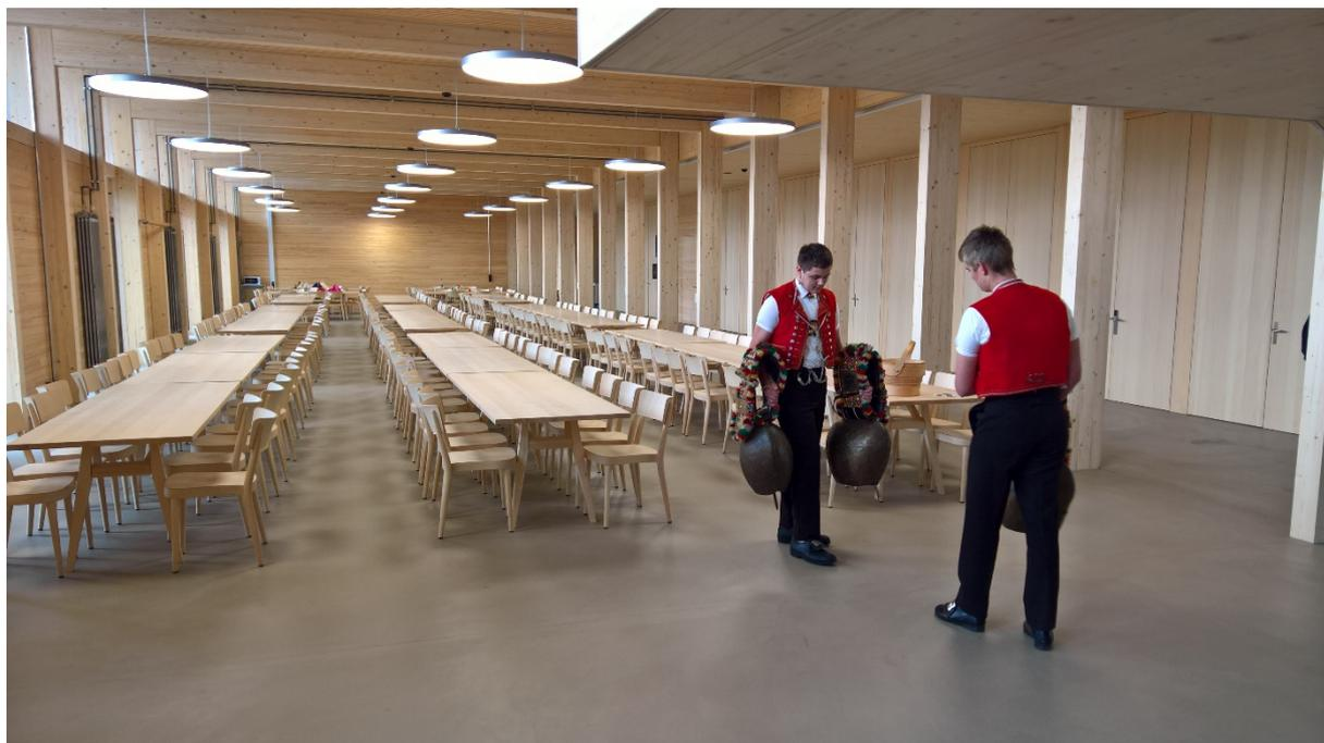
*Die Holzbaustruktur des LSZG ist auch im Innern des Gebäudes wahrnehmbar. Die Unterrichtsräume, Mensa und Aula können über manuell bedienbare Klappen quergelüftet werden. Die Rasterstruktur ermöglicht eine enorme Grundrissflexibilität. Der Strukturwandel aus den Bedürfnissen des Betriebs kann so laufend im Gebäude angepasst werden.*
