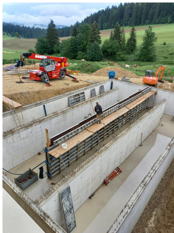
Citerne en construction
