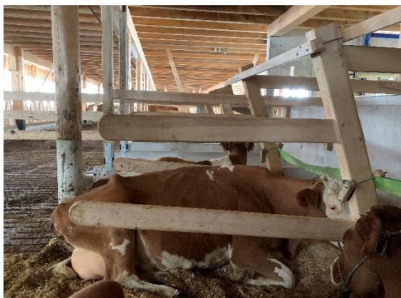
Die Trennbügel sind vollständig aus Holz gefertigt.
