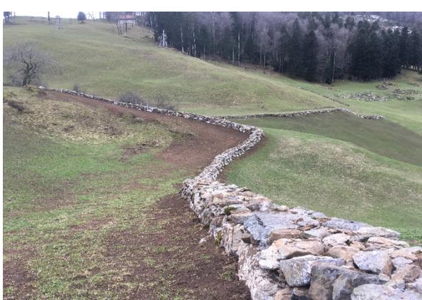
*Die zweihäuptige Mauer Geissmattli (Seite Oberbürgen), welche teilweise nur aus einer Steinbreite bestand, war auf ihrer ganzen Länge instabil. Stellenweise konnte durch die Mauer geblickt werden. Nach der Sanierung: Mit den zahlreichen umliegenden Steinen wurde die Mauer mit einer Breite von ca. 0.8 m neu aufgebaut. Sie stellt ein sehr markantes Element in der Landschaft dar. Zweihäuptige Trockenmauern sind auf dem Gemeindegebiet von Ennetbürgen nicht häufig anzutreffen.*
