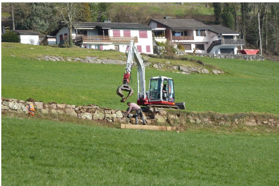
*Sanierung der oberen Grenzmauer im Gebiet Tuschmatt. Hier arbeitet der Grundeigentümer mit. Holztafeln schützen das unterliegende Gelände von weggrollenden Steinen.*
