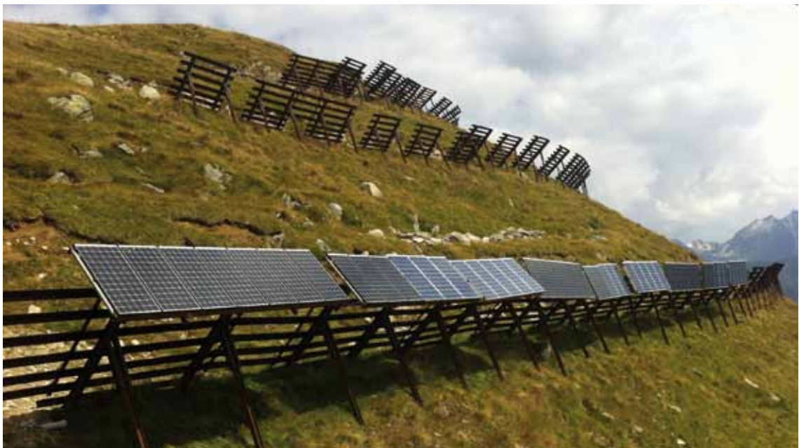
Abbildung 5.1: Pilotanlage Bellwald: Photovoltaikanlage an bestehenden Lawinverbauungen. Quelle: Enalpin AG.
